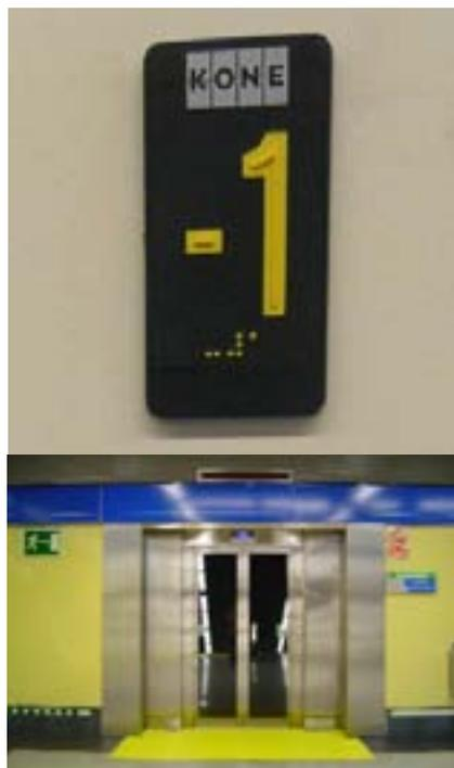
Señalización del número de planta en braille y en altorrelieve. Franja de señalización frente a puerta de ascensor con pavimento de color contrastado y con textura de acanaladura homologada.
