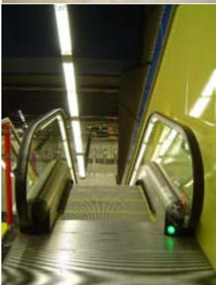
*Escaleras mecánicas con pavimento de señalización podo-táctil en el rellano. La luz verde indica el sentido de desplazamiento de la escalera, en dirección de bajada.*
