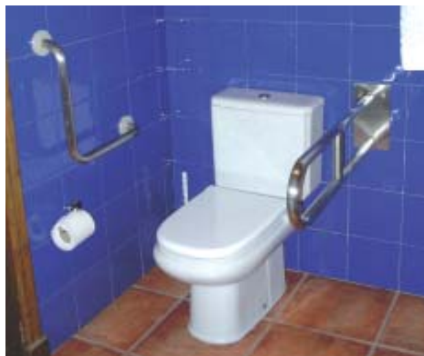
Barra fija en el lado de la pared y abatible en el lado de la transferencia. En la segunda fotografía se requiere quitar el asiento para no reducir el área de maniobra de la persona en silla de ruedas
