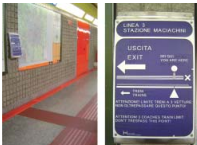
Señalización de plano en relieve mediante franjas guía de encaminamiento. Ejemplo de Plano en relieve con información direccional y textos en braille
