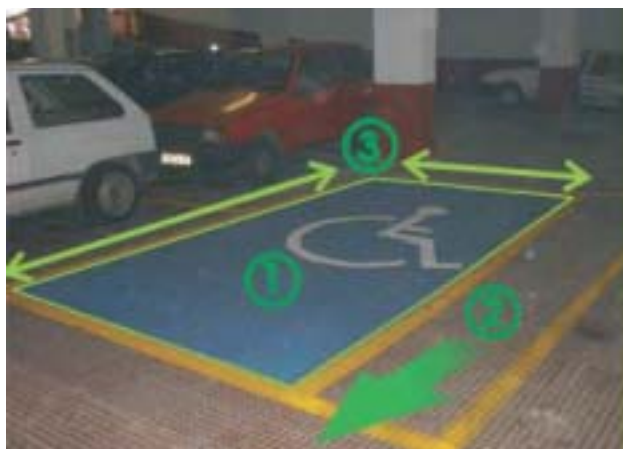
Señalización horizontal de plaza de aparcamiento reservada
